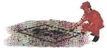
2- Recortar o revestimento a ser removido conforme a área escolhida, com o auxílio de equipamento mecânico, martetele pneumático ou serra clipper preferencialmente. A utilização de chibancas e picaretas só é recomendável quando o pavimento tiver espessura inferior a 5 cm.
