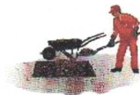
4- Efetuar a limpeza da área utilizando vassouras ou compressor. Na varrição ou limpeza com o compressor, retirar todo o pó que estiver solto. Com um regador, espalhar pouca água, suficiente para assentar a poeira e garantir a inexistência de pó solto, se necessário. A varrição ou a limpeza com o compressor deverá se estender sobre o pavimento existente, numa área maior que a prevista para a pintura de ligação.
