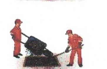
Em seguida, executa-se uma primeira compactação (4 passadas com compactador tipo placa vibratória) aplicando em seguida uma nova camada de massa. A aplicação desta nova camada deverá atingir toda a área pintada (10 a 20 cm externos ao recorte).
