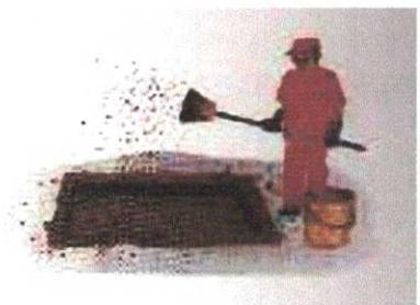
6- Preencher o local com CBUQ Faixa C, na temperatura entre 110°C e 177°C, ou PMF de graduação densa na temperatura ambiente. O preenchimento deve ser cuidadoso e ser iniciado 5 (cinco) minutos após a execução da pintura de ligação, devido à necessidade de ruptura da emulsão asfáltica. Com a utilização de rastelo
