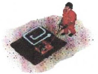
Atenção especial deve ser dada na compactação da camada na junção da massa nova com o pavimento velho, evitando deixar aberturas que permitam a penetração de água, quer de chuva, quer lançada na rua por moradores. No caso de trechos de comprimento superior a 20 metros e 3 metros de largura, é recomendável a utilização de compactador de maior potência, tipo CC800, ou equivalente.
