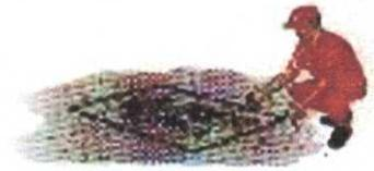
2- Recortar o revestimento a ser removido, com a utilização de equipamentos mecânicos tipo martetele pneumático e/ou serra clipper, preferencialmente. A utilização de chibancas e picaretas deve ser evitada devido a baixa produtividade e a dificuldade de se romper espessuras consideráveis sem trincar ou abalar o pavimento que não necessite ser removido. É fundamental que a face do recorte faça um ângulo de 90° com o revestimento existente.
