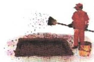
6- Preencher o local com CBUQ Faixa C, na temperatura entre 110°C e 177°C, ou PMF de graduação densa na temperatura ambiente, no mínimo três camadas. O preenchimento deverá ser iniciado 5 (cinco) minutos após a execução da pintura de ligação devido à necessidade de ruptura da emulsão asfáltica. Colocar a 1ª camada, máximo de 5 cm de espessura, nivelamento abaixo do pavimento existente.
