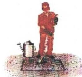
5- Executar a pintura de ligação no fundo e nas paredes verticais da área recortada, utilizando emulsão asfáltica tipo RR – 1C, pura, ou diluída no máximo com 20% (vinte por cento) de água, a critério da fiscalização. A emulsão deve cobrir toda a área que vai receber a massa asfáltica, sem se acumular em poças. Deve-se estender a pintura de ligação por 10 a 20 cm sobre o pavimento existente, isto é, para cada lado do buraco.
