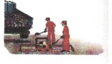
8- Executar a pintura de ligação no fundo e nas paredes verticais da área recortada, utilizando emulsão asfáltica tipo RR-1C, pura, ou diluída no máximo com 20% (vinte por cento) de água, a critério da fiscalização. A emulsão deve cobrir toda a área que vai receber a massa asfáltica, sem se acumular em poças. Deve-se estender a pintura de ligação por 10 a 20 cm sobre o pavimento existente, isto é, para cada lado do buraco.
