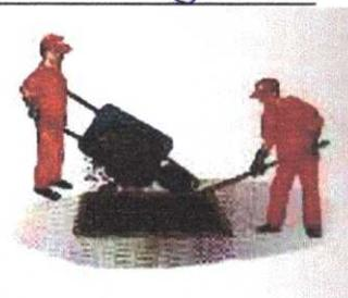
7- Espalhar pouca água sobre toda a camada final da massa, utilizando-se de um regador. Não pode ocorrer formação de poças. O objetivo é facilitar o deslizamento do compactador sobre a massa e proporcionar um acabamento liso quando da operação de compactação final.
