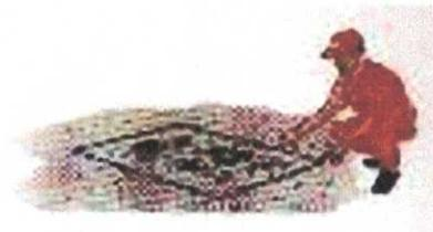
2- Recortar o revestimento a ser removido, com a utilização de equipamentos mecânicos tipo martetele pneumático e/ou serra clipper, preferencialmente. A utilização de chibancas e picaretas devem ser evitadas, devido a baixa produtividade e a dificuldade de se romper espessuras consideráveis sem trincar ou abalar o pavimento que não necessite ser removido. É fundamental que a face do recorte faça um ângulo de 90° com o revestimento existente.
